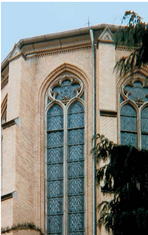
Použití pocínované feritické oceli třídy 1.4510, u svislých odváděcích rour na budově historicky cenného kostela
