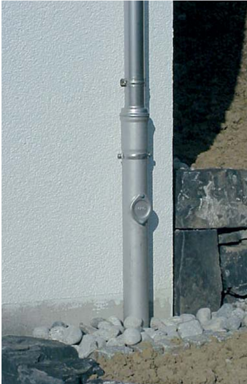
Svislá roura s krytem servisního otvoru
